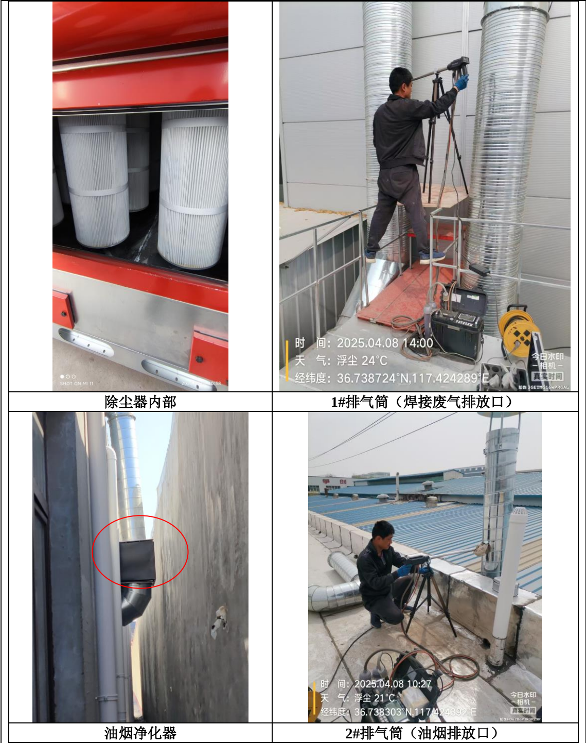
图 3-1 环保设备、检测平台及采样孔现状图
