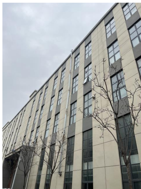
图 3-3(b) DA002 废气排气筒
